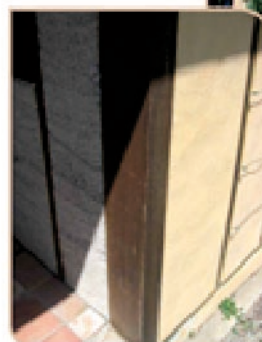
Isolation de l'ancien bois de charpente (photo : J. Arnaud)
