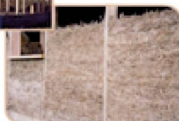
Mélange terre/paille banché (photo F. Bonnet)
