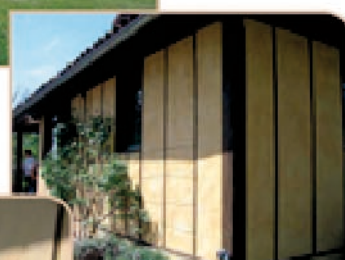
Remplissage bois de charpente (photo : J. Arnaud)
