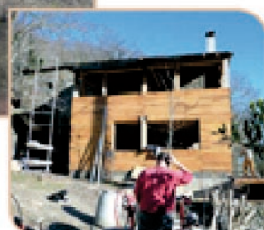
Remplissage bois de charpente (photo : J. Arnaud)
