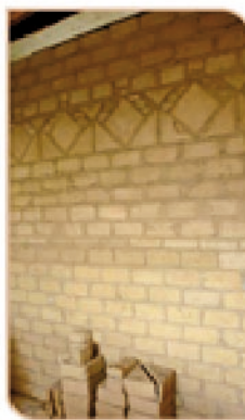
Boîtes de terre crue (briques) empilées
