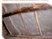
Isolation avec ouate de cellulose (photo : J. Arnaud)
